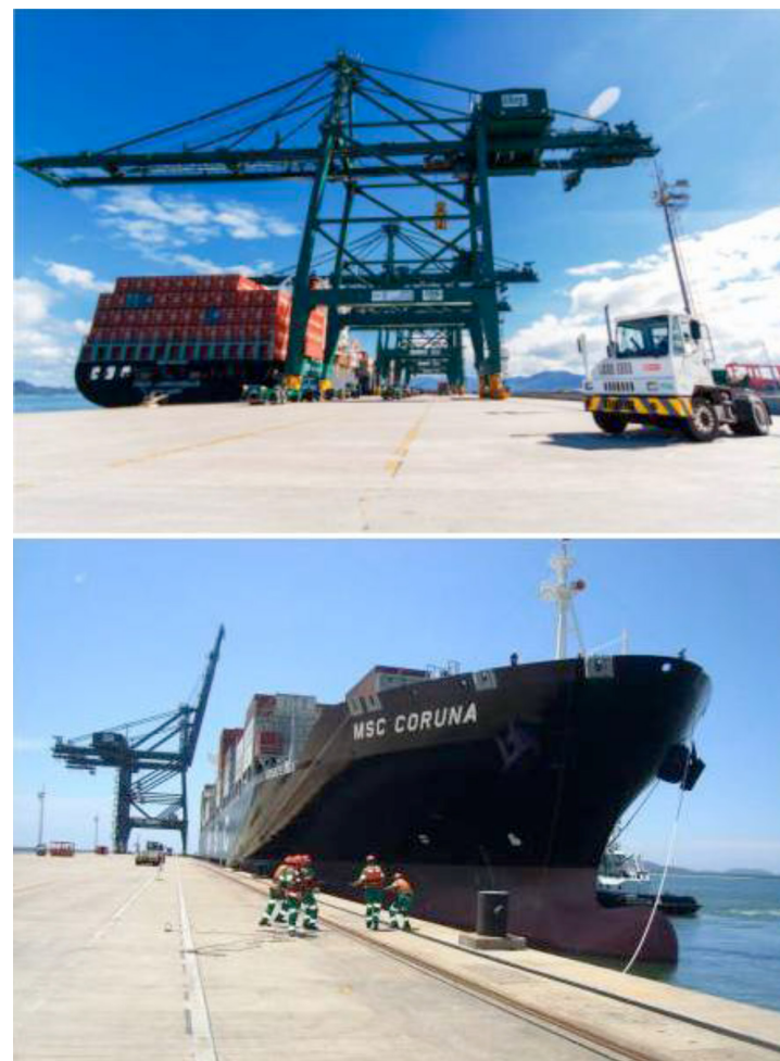
Figura 6. Porto Itapoá em operação.
