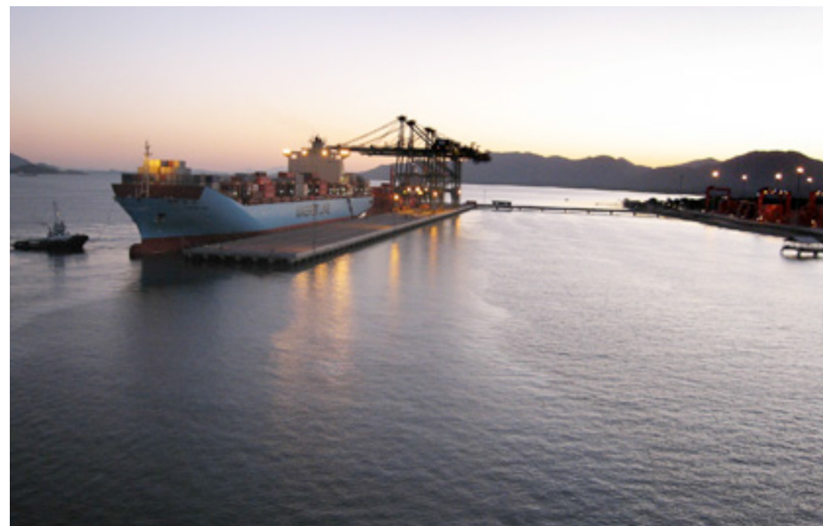
Figura 3. Porto Itapoá às margens da baía da Babitonga, Município de Itapoá, Santa Catarina.
